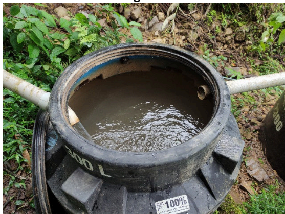
Fotografía 5. Tanque de captación y tubería de ingreso
