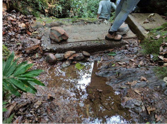
Fotografía 2. Obra de captación
