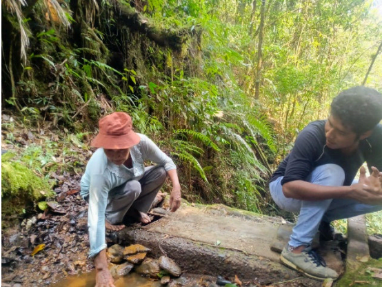
Fotografía 3. Vista de obra de captación del agua
