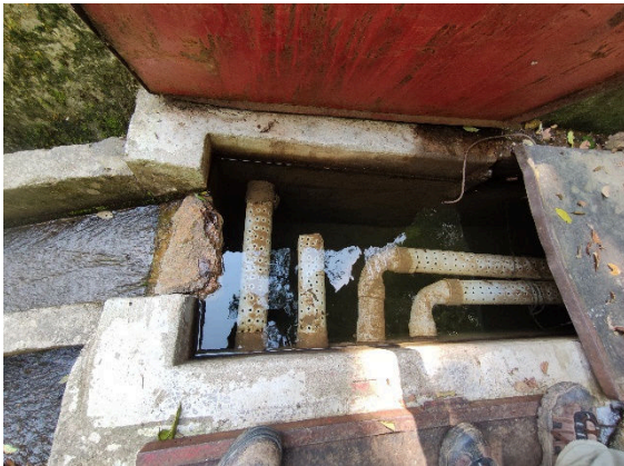
Fotografía 3. Cámara de captación
