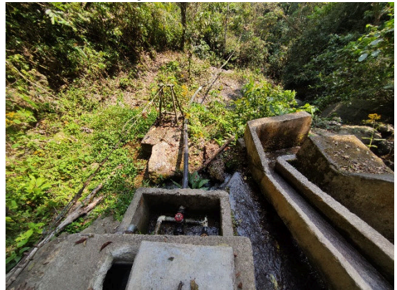
Fotografía 4. Vista del vertedero, cámara de llaves y tubería de aducción
