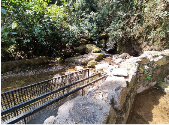
Fotografía 3. Cámara de captación
