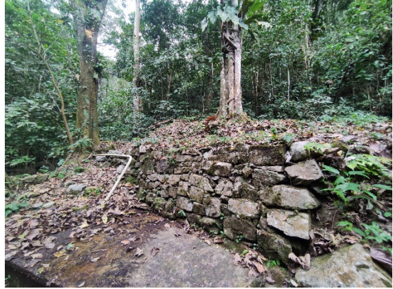
Fotografía 2. Protección de la vertiente con muro de piedras
