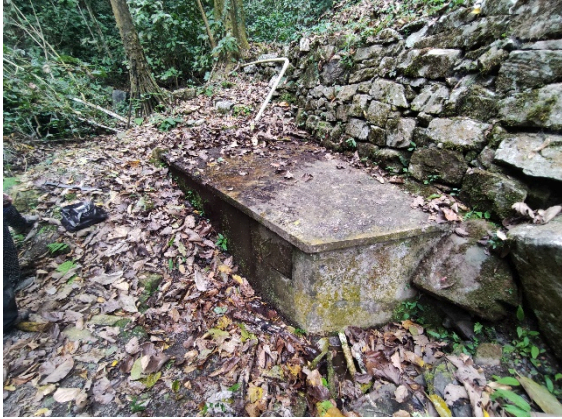
Fotografía 1. Obra de captación de vertiente de ladera
