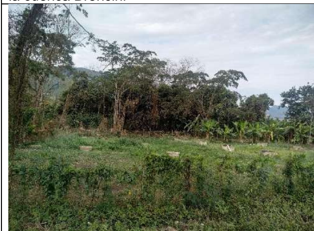
Caranavi 04/09/2019 área de tratamiento de agua servida.
