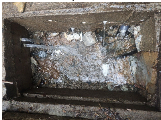
Fotografía 5. Cámara de ingreso a obra de captación
