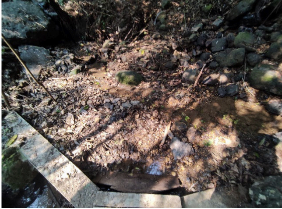
Fotografía 3. Colmatación de la obra de captación por el arrastre de material
