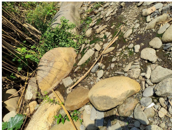
Fotografía 5. Descarga de aguas residuales de actividades de la comunidad
