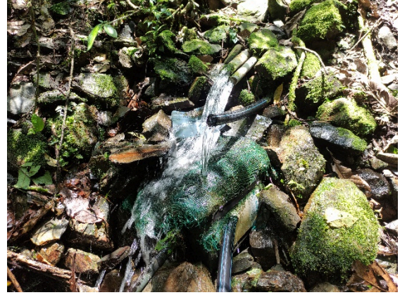
Fotografía 2. Agua captada con un bidón y conducido a tanque plástico
