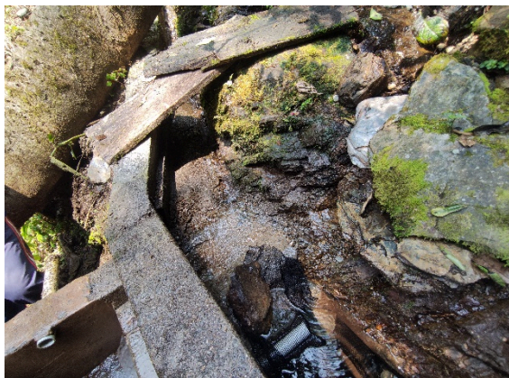
Fotografía 3. Muros de protección del afloramiento
