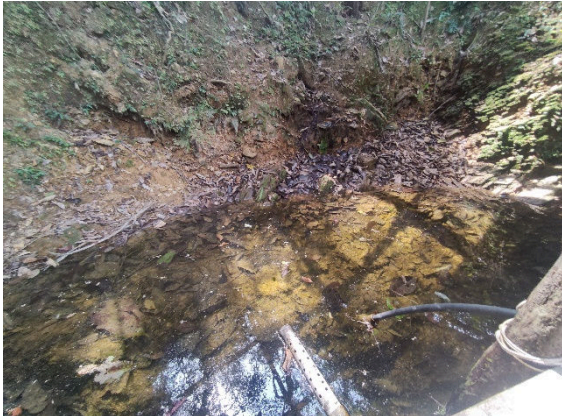
Fotografía 3. Vista del agua retenida en la micropresa
