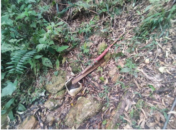
Fotografía 1. Captación del afloramiento de la vertiente
