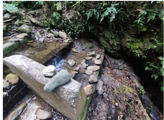
Fotografía 6. Desfogue de cámara de captación, lugar de medición de caudal
