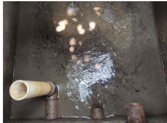
Fotografía 4. Vista del agua en cámara
