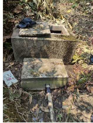
Fotografía 2. Cámara desarenadora y sitio de muestreo
