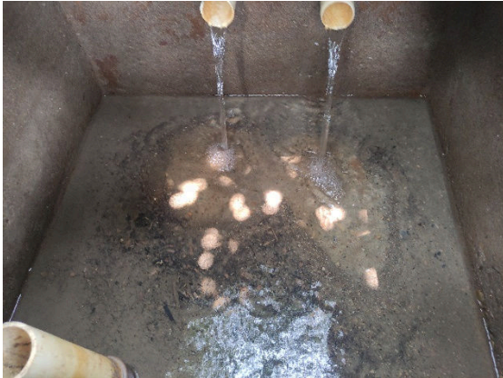
Fotografía 3. Ingreso de agua a cámara desarenadora, sitio de medición de caudal
