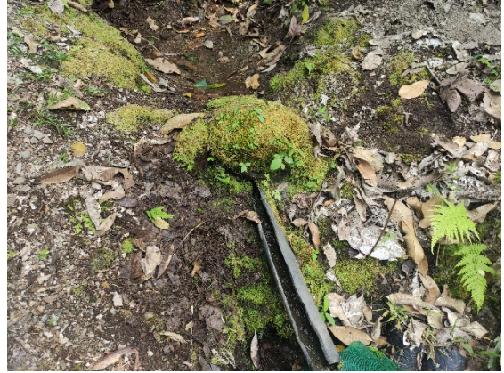
Fotografía 2. Conducción del agua del afloramiento
