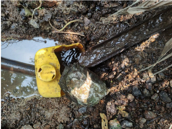
Fotografía 3. Captación con un bidón y derivación a politubo
