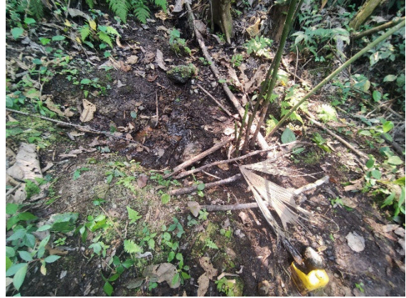
Fotografía 2. Vista del escurrimiento hacia la captación
