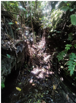
Fotografía 3. Vista del área de escurrimiento de agua
