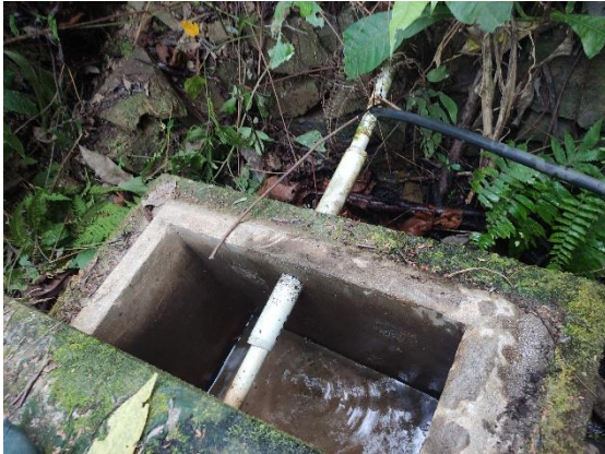
Fotografía 3. Vista de la tubería de ingreso a cámara de captación
