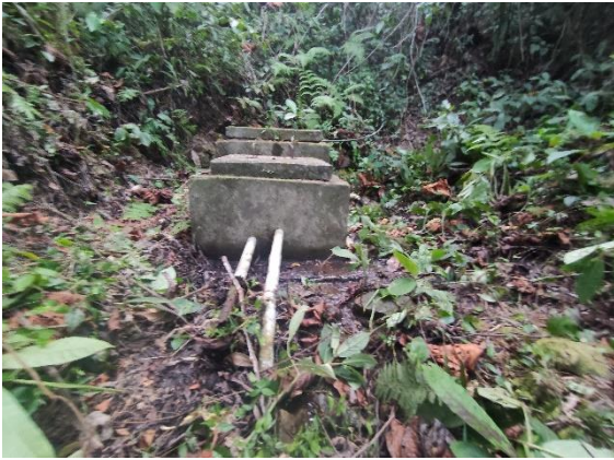
Fotografía 3. Vista de la tubería de ingreso a cámara de captación
