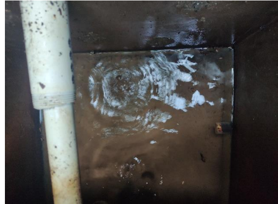
Fotografía 4. Vista del agua al interior de la cámara, sitio de muestreo
