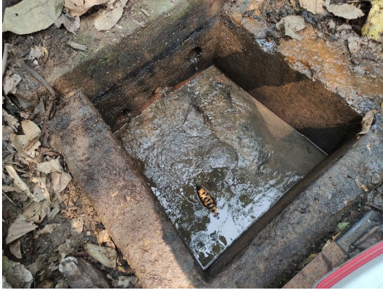
Fotografía 1. Obra de captación y sitio de toma de muestras de agua
