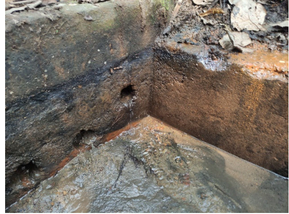
Fotografía 2. Ingreso del agua de la vertiente a la cámara
