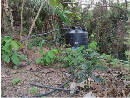
Fotografía 3. Tuberías de entrada a tanque de almacenamiento
