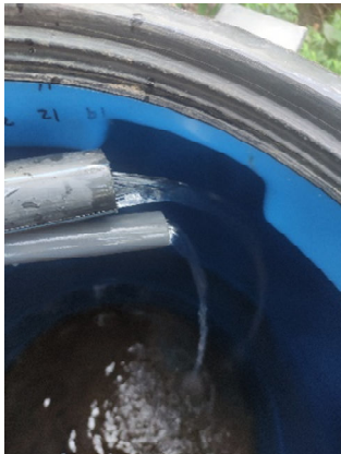
Fotografía 3. Tuberías de entrada a tanque de almacenamiento
