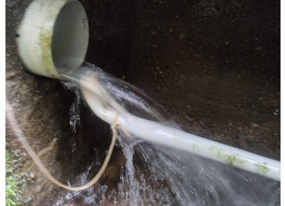
Fotografía 4. Ingreso de agua de fuente 2 a cámara
