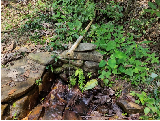
Fotografía 1. Vertiente captada con tubería
