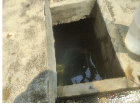
Fotografía 2. Vista del agua al interior del tanque
