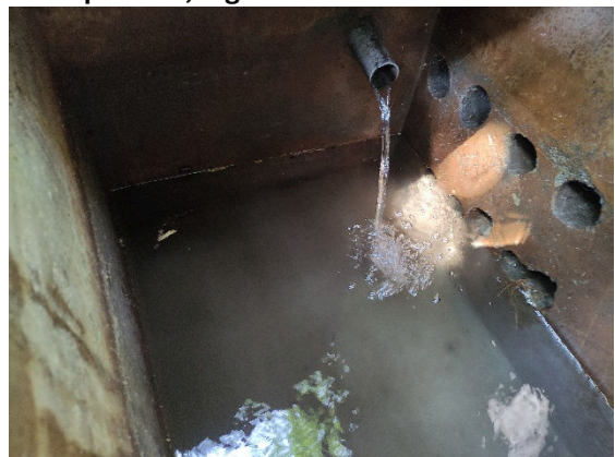
Fotografía 6. Tubería de ingreso a cámara de captación, lugar de medición de caudal
