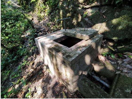
Fotografía 3. Captación del escurrimiento de la vertiente con tubería
