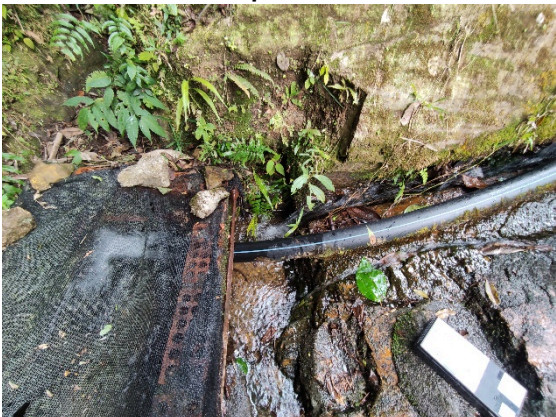
Fotografía 3. Descarga de agua en cámara de captación
