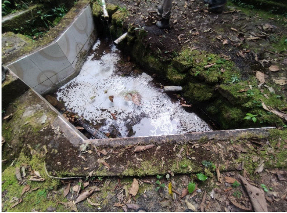
Fotografía 3. Barbacanas captando el agua de la vertiente (sitio de medición de caudal)
