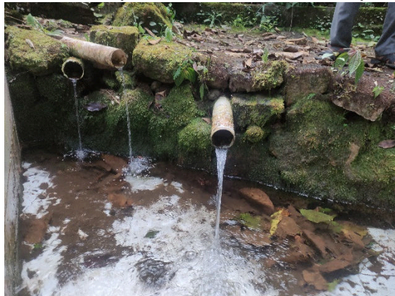
Fotografía 3. Barbacanas captando el agua de la vertiente (sitio de medición de caudal)
