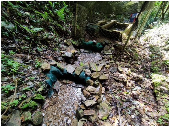
Fotografía 5. Fosas de retención de sólidos antes del ingreso a la estructura de captación
