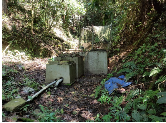
Fotografía 2. Obra de captación del sistema de agua de la comunidad, vista frontal
