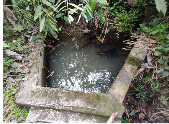
Fotografía 2. Muros de protección del afloramiento
